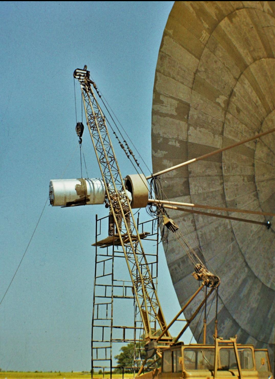
Montaż pojemnika ogniskowego z aparaturą odbiorczą.
