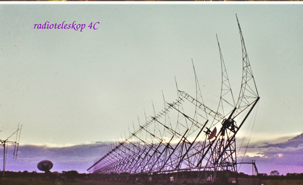
Antena ruchoma radioteleskopu jednomilowego
